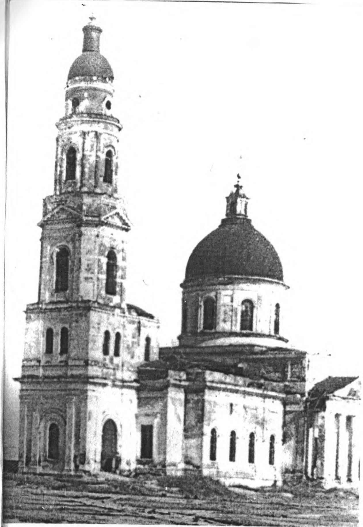
Вид с юго-запада. Пересъемка с фото Миронова А.Н. 1953г. из Дединовского школьного краеведческого музея. /Архив в/о "Совз-реставрация" нег. № 72847 /
